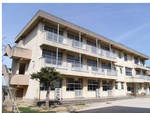
(九州開発センターが入居する旧荒尾第二小学校)
